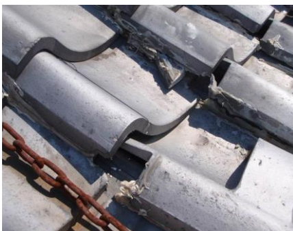
屋根瓦のズレ・破損
