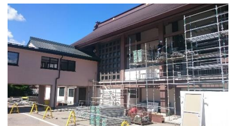
西側足場解体
