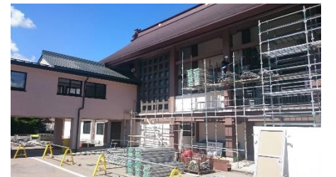
西側足場解体
