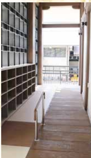
【本堂回廊】回廊をバリアフリー化し下足箱を設置しました。回廊が広々となりました。
