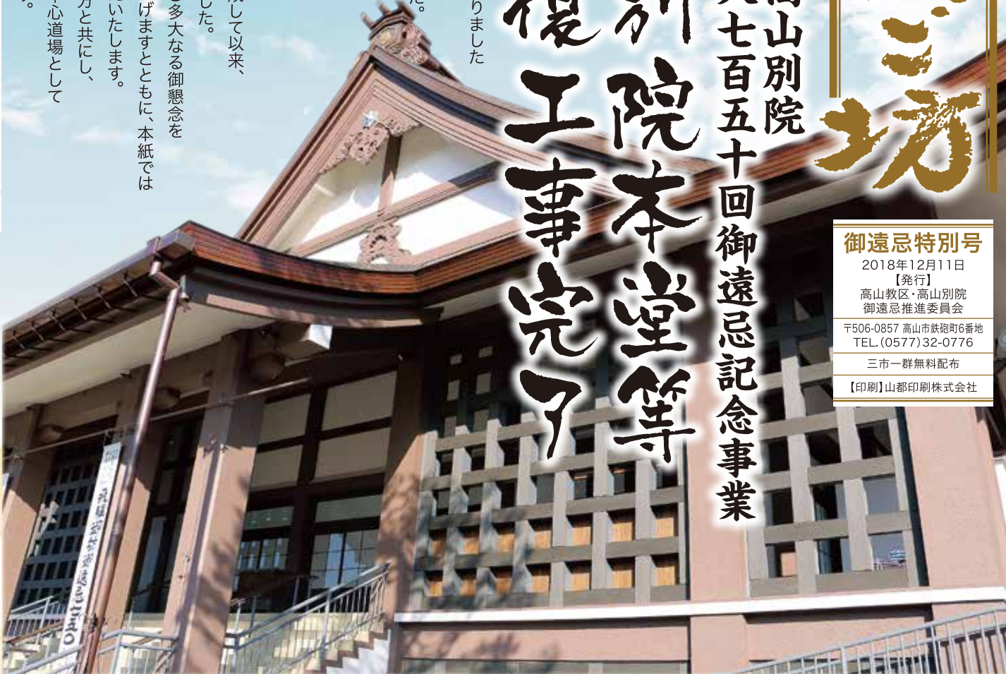
【耐震構造を備えた本堂】本堂正面の耐震補強工事は、景観を配慮しH鋼材を格子状に組み上げ、表面に千鳥格子のイメージで木調の化粧材が敷設されました。また、壁面全体には、中性化防止の塗装が施されました。
