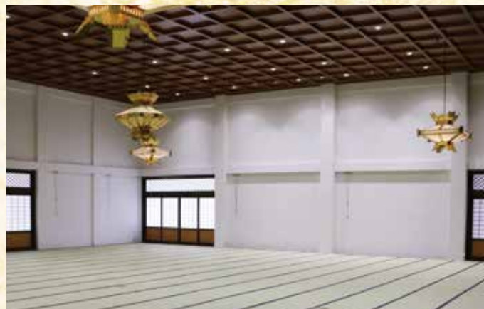
【本堂内耐震補強壁】本堂内の耐震補強壁は、合計8カ所に施工されました。これにより、阪神淡路大震災程度の地震でも倒壊しないレベルの耐震性が確保されました。また、室内温度の安定化により暑さ寒さ対策にもなりました。
