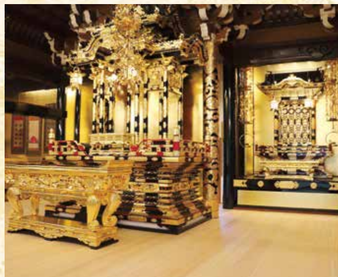
【本堂内陣】見違えるほど美しく修復がなされました。主な修復内容として、中尊前須弥壇宮殿、宗祖厨子、卓、巻障子、框など。また、壁や襖の金紙張り替えや本間床板の新調などが実施されました。
